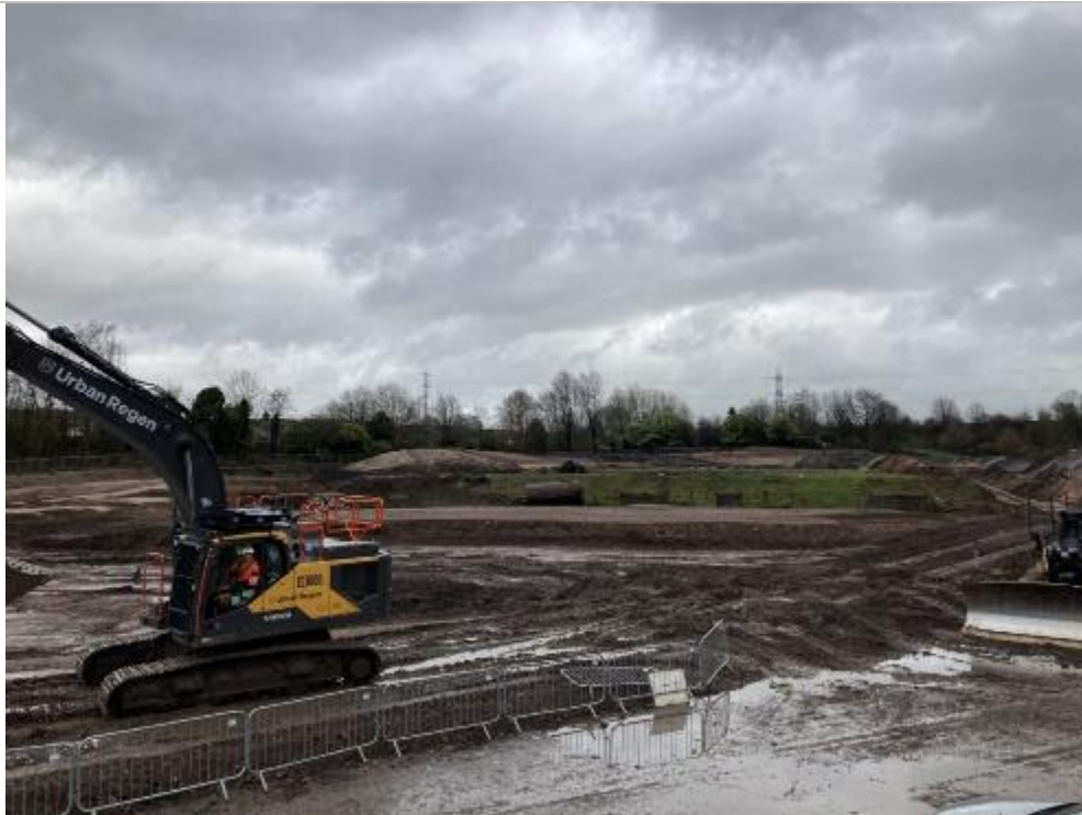
PLATE 53 CUT AND FILL (AREA 2A)
