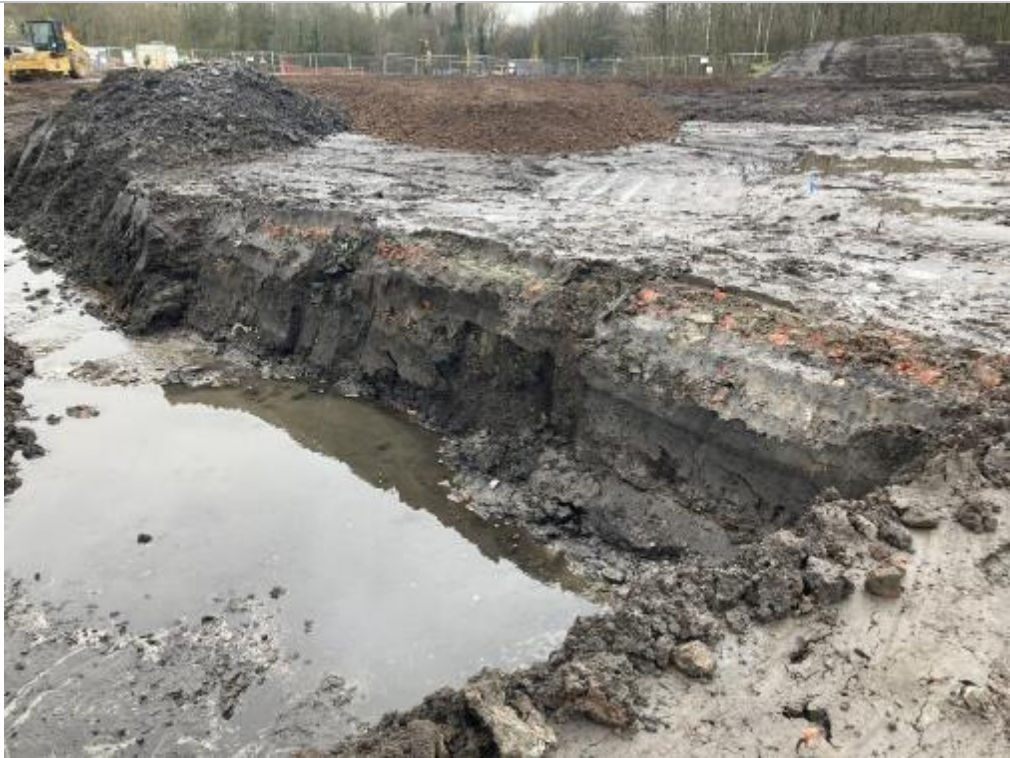
PLATE 51 CUT AND FILL (AREA 2A)
