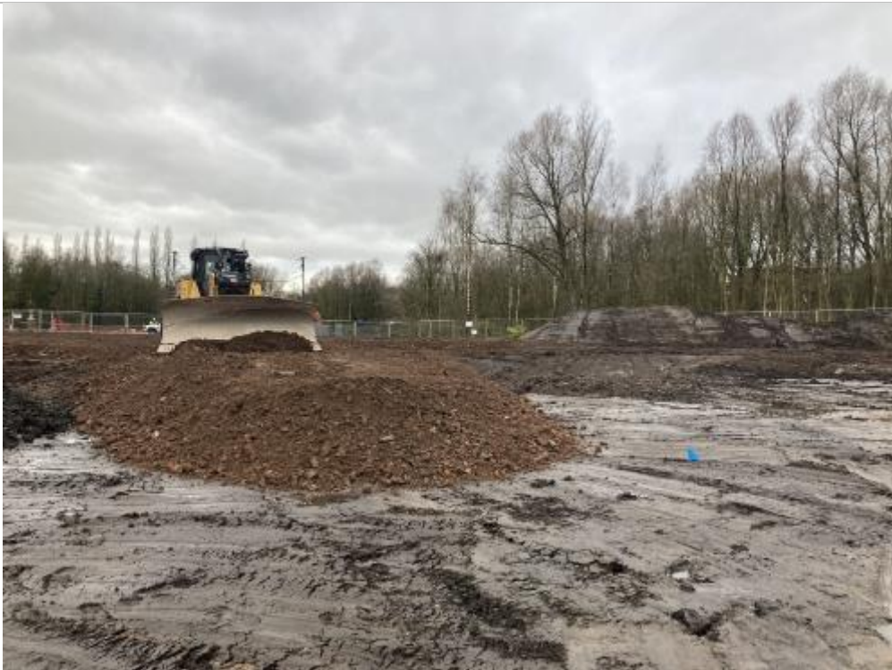
PLATE 52 CUT AND FILL (AREA 2A)
