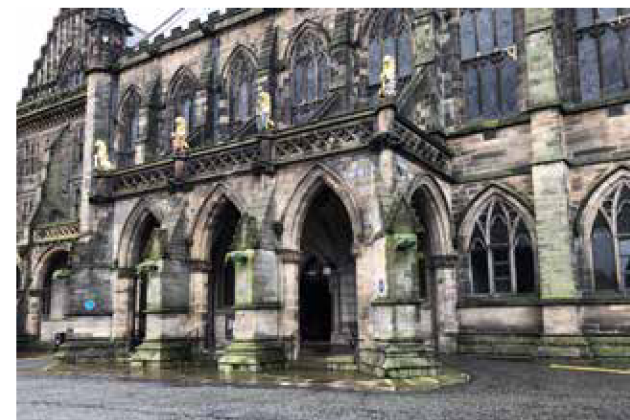
Existing porte cochere
