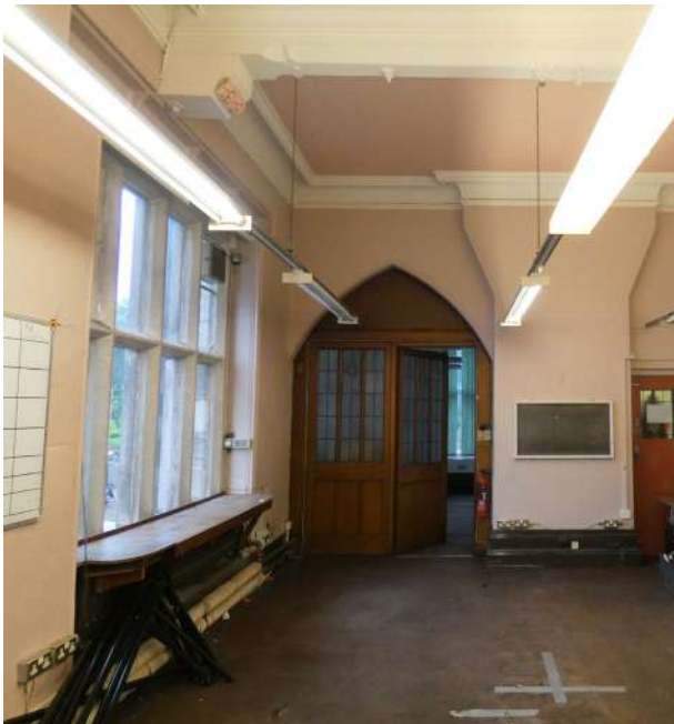
3.1 F6c Unused Room
