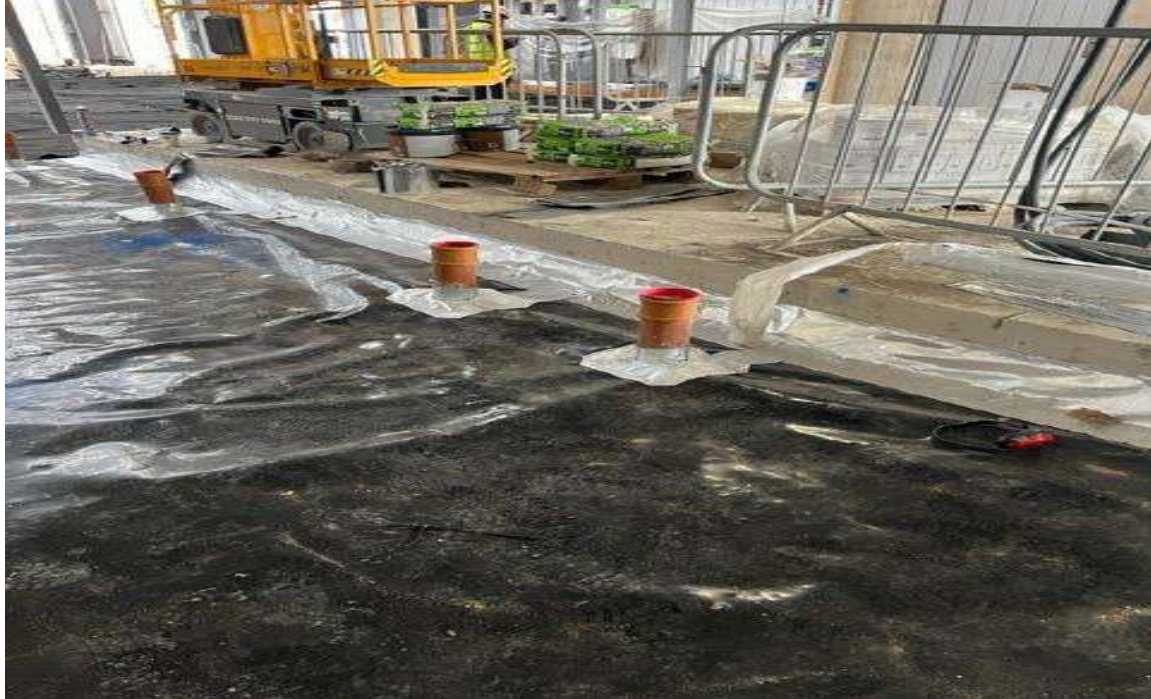
RTEC4 Gas membrane ( Black) RTEC GRSAM (silver)
