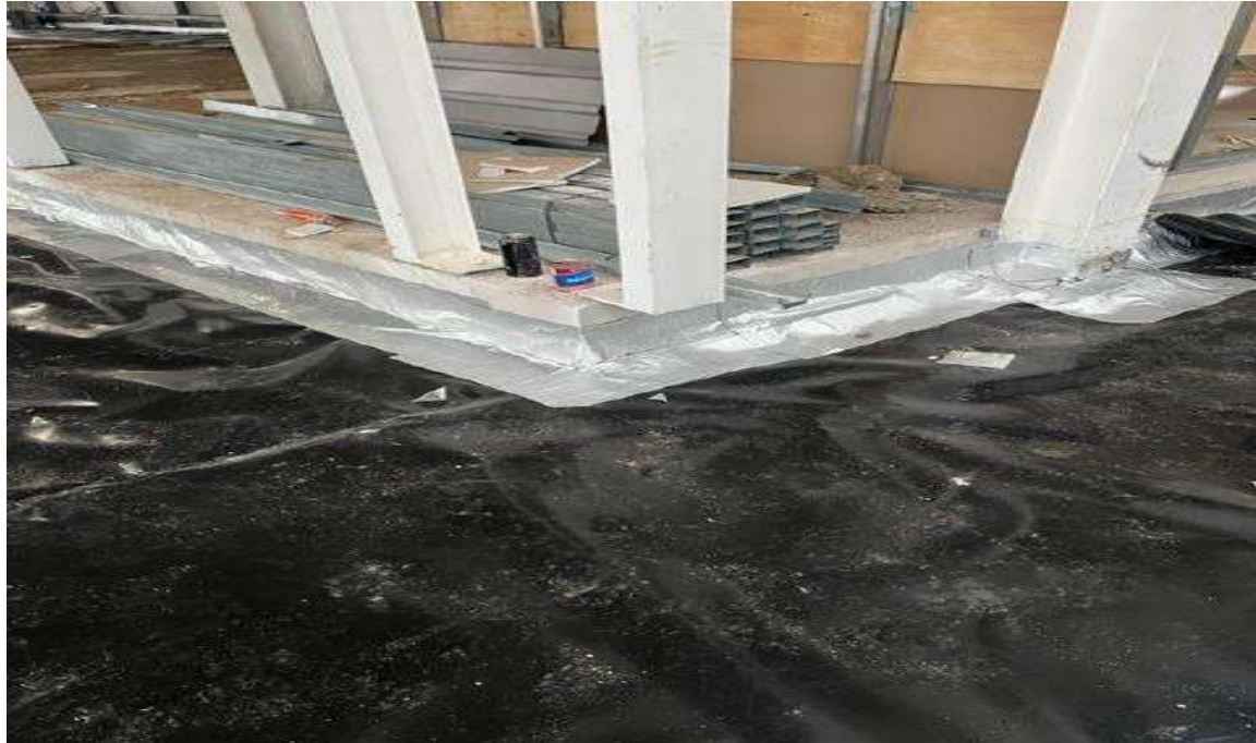
RTEC4 Gas membrane ( Black) RTEC GRSAM (silver)
